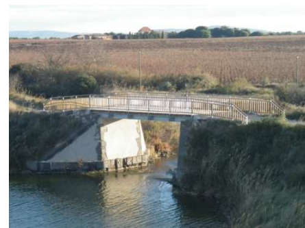
Pont de koch avec gardes corps
