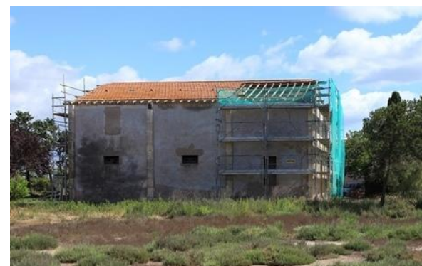
Rénovation du bâtiment de stockage de foin
