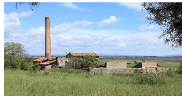
Cheminée de Maraval
